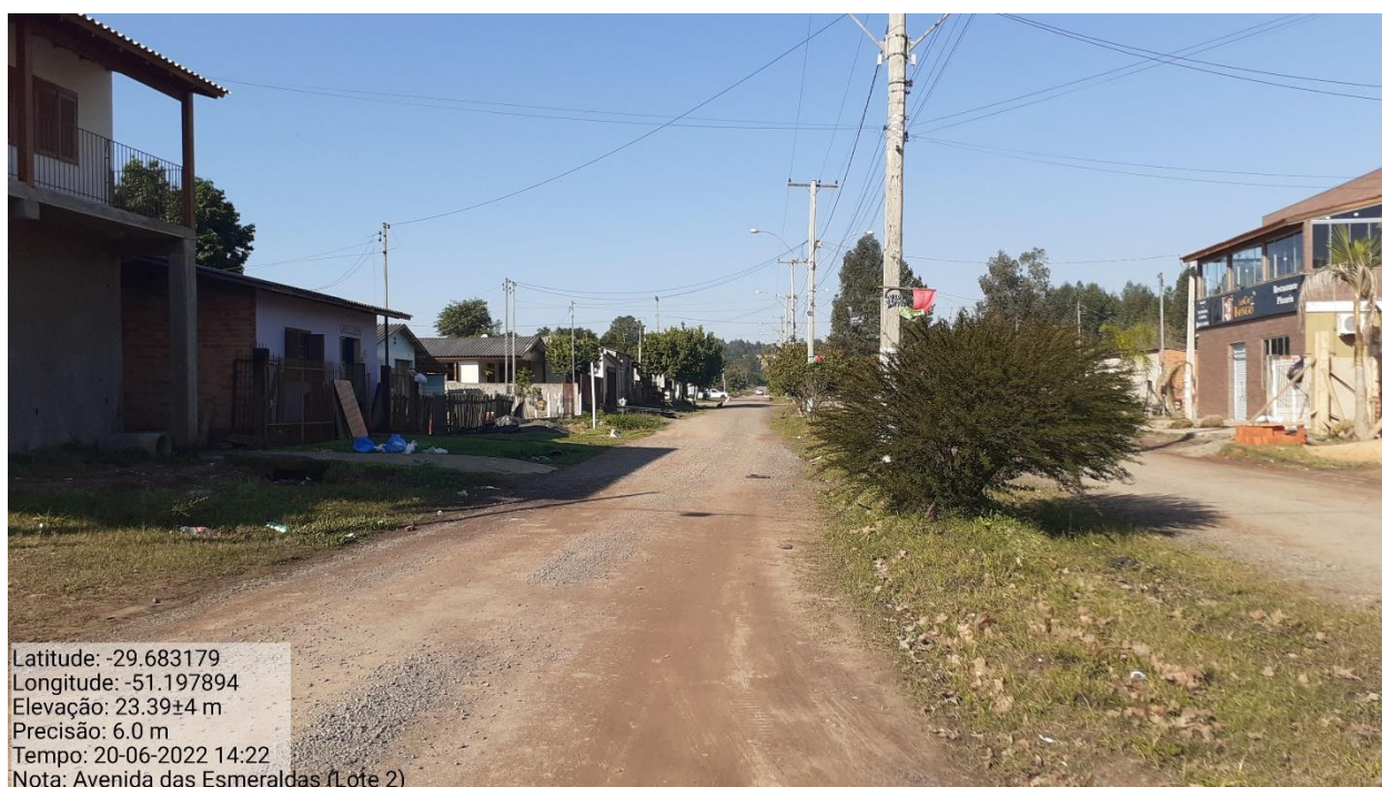
Foto 1: Avenida das Esmeraldas – Início do Trecho
