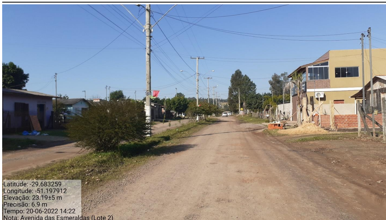
Foto 2: Avenida das Esmeraldas –Início do Trecho
